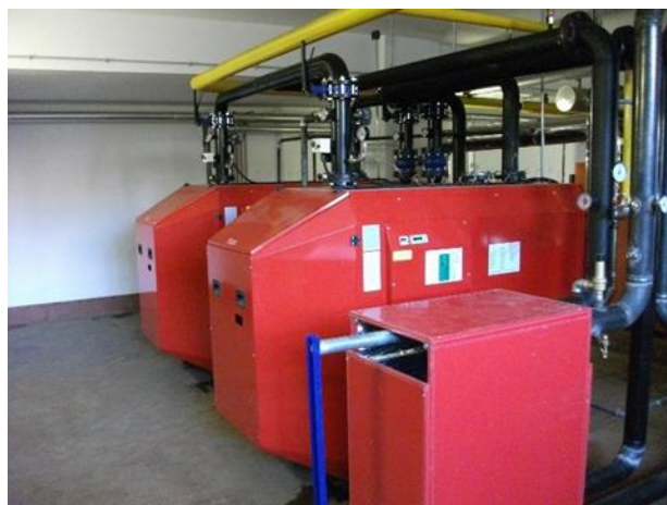
Figura 4.11 - Particolare di caldaia a basamento
