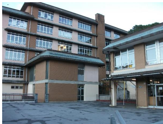
Figura 0.1 - Vista della facciata esposta a Sud -Ovest
