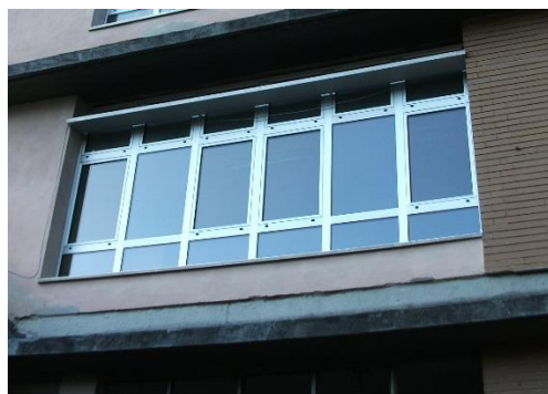
Figura 8.1 – Esempio del vecchio tipo di infissi presenti
