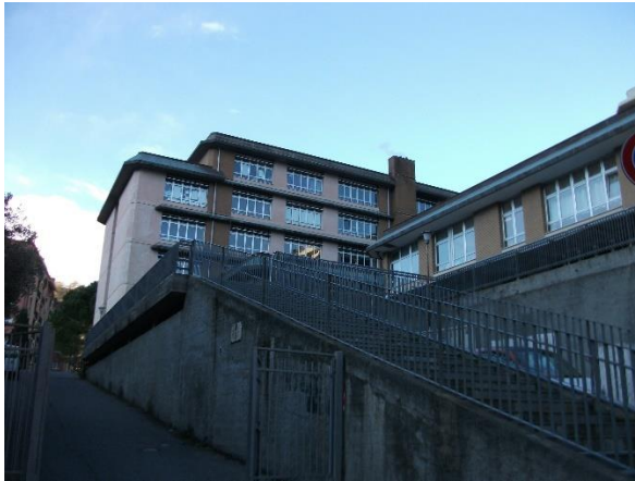
Figura 4.2 - Particolari della facciata
